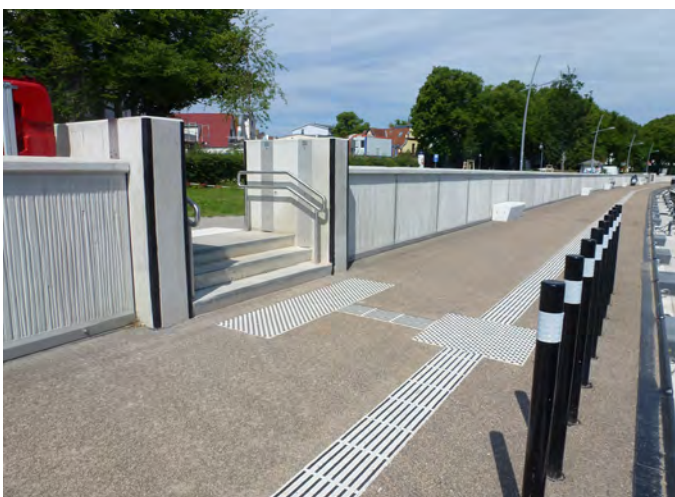
▲ Hochwasserschutzwand in Warnemünde.
